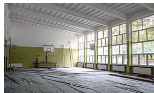
Prace prowadzone były także na sali gimnastycznej „sportowej trójki”.
