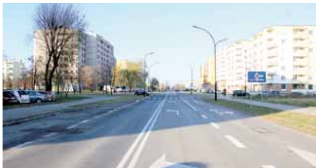
Ulica Kopernika wymaga gruntownej modernizacji. Miasto ma szansę, by połowę kosztów inwestycji pokryła dotacja z budżetu państwa.
